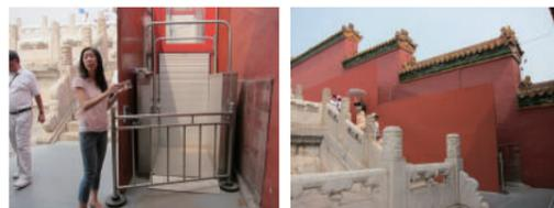
写真7 (左) 太和殿のリフト(壁面に内蔵されたタイプのリフト)、(右) リフトの外側の二重壁
