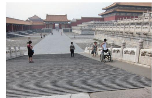
写真6 太和殿周囲の緩やかな傾斜路。アクセシブルルート確保のためレンガ素材は変えずに再整備
