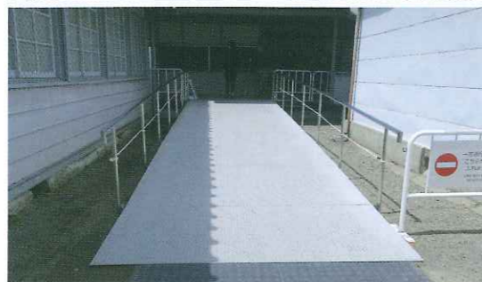
写真6 敷地内の建物入口で目につく鉄板仮設スロープ
