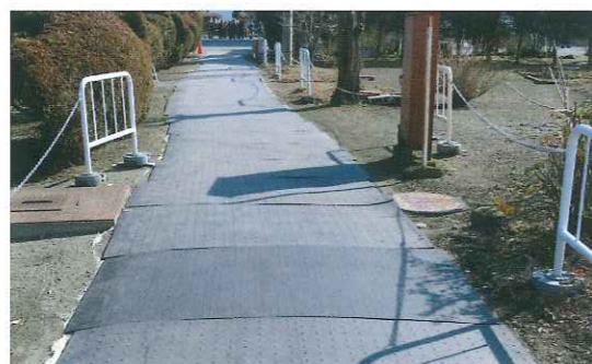
写真5 見学ルート。史跡保存のためゴム製マットによる簡易舗装
