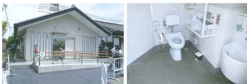
写真9 (左) 新設された公衆トイレ(車いす使用者、オストメイト、乳幼児連れ対応)、写真10 (右) 車いす使用者用トイレ内部
