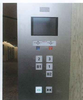
図5(左)エレベータかご内の聴覚障害者用非常ボタンとモニター。映像で聴覚障害者であることを知らせることができる(国立競技場) 図6(左)補助犬トイレ。屋外と屋内に1箇所ずつ設置(国立競技場) 図7(左)場内1階の視覚障害者誘導用ブロックと床サイン(国立競技場) (提供・高橋儀平)
