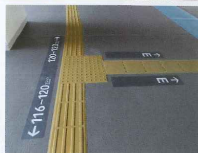
図5(左)エレベータかご内の聴覚障害者用非常ボタンとモニター。映像で聴覚障害者であることを知らせることができる(国立競技場) 図6(左)補助犬トイレ。屋外と屋内に1箇所ずつ設置(国立競技場) 図7(左)場内1階の視覚障害者誘導用ブロックと床サイン(国立競技場) (提供・高橋儀平)
